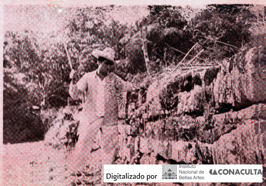
LA MALEZA QUE LAS CUBRE YA ESTÁ DESINTEGRANDO LAS CONSTRUCCIONES...
