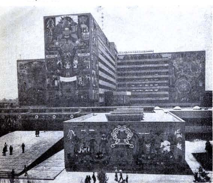
EL NUEVO edificio de la SCOP ha sido uno de los experimentos más importantes para la aplicación de las nuevas teorías arquitectónicas.
